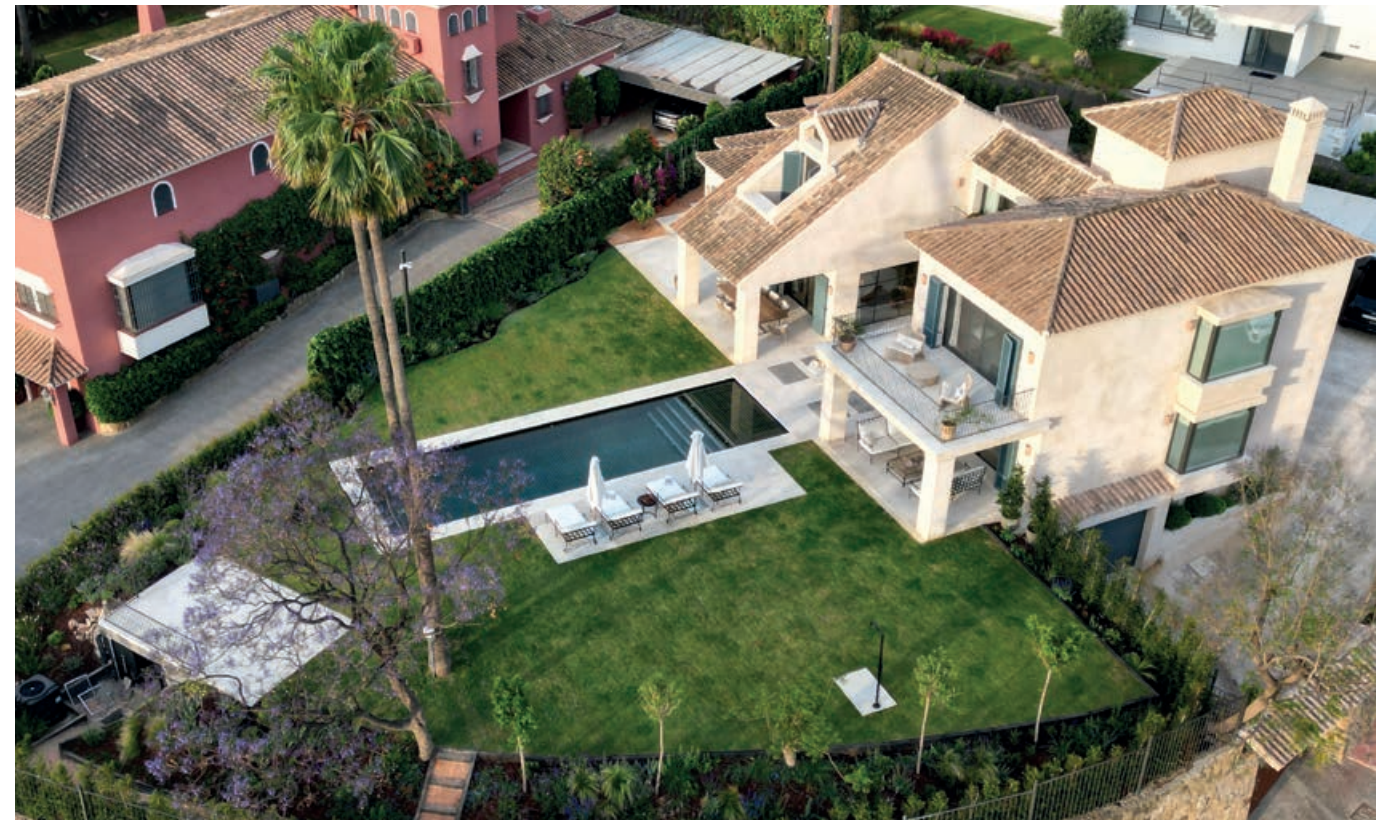
Villa Casiopea - Nueva Andalucía (Málaga) Rehabilitación / Refurbishment
