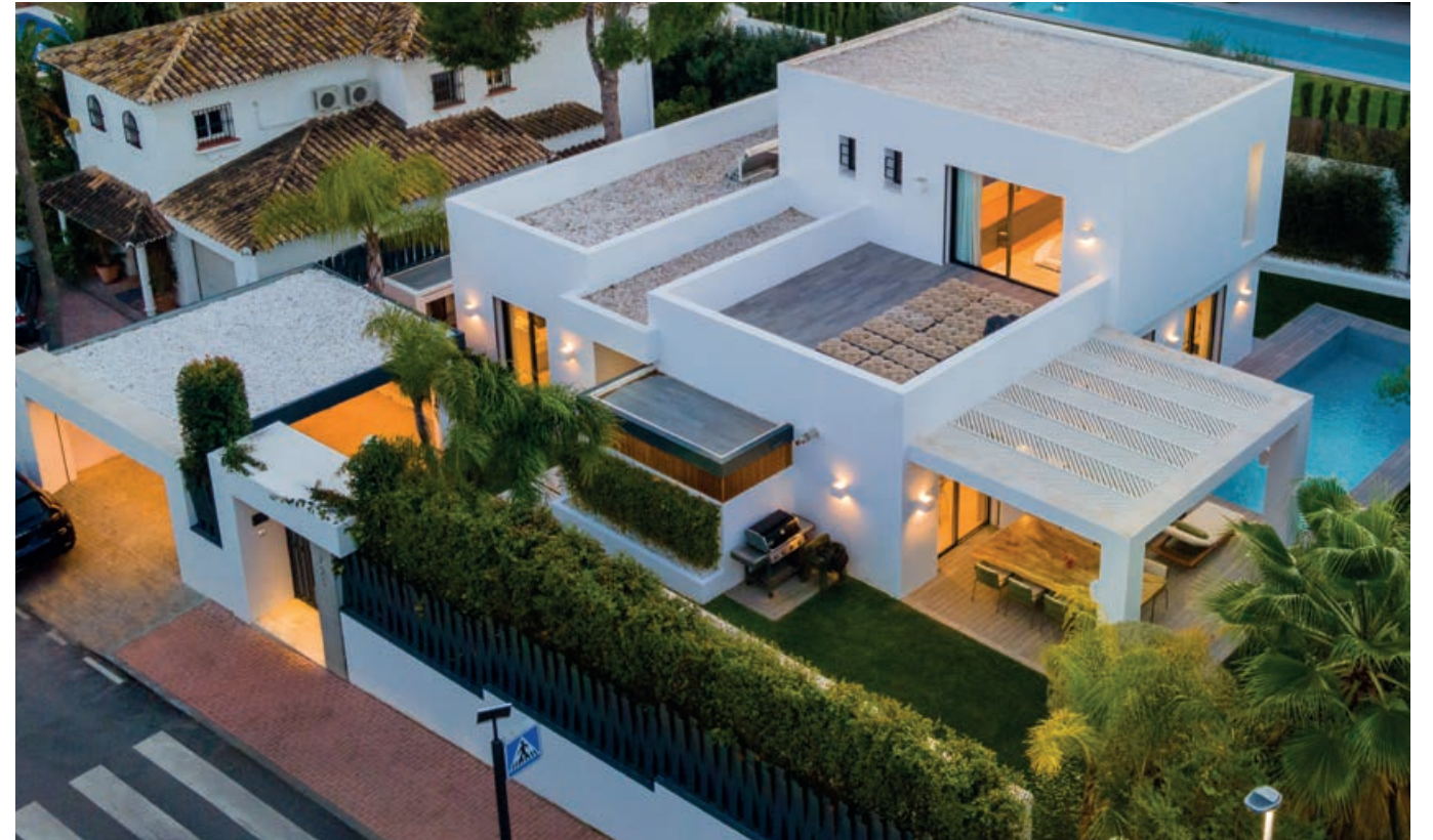
Villa Guadalmina - Marbella (Málaga) Rehabilitación / Refurbishment
